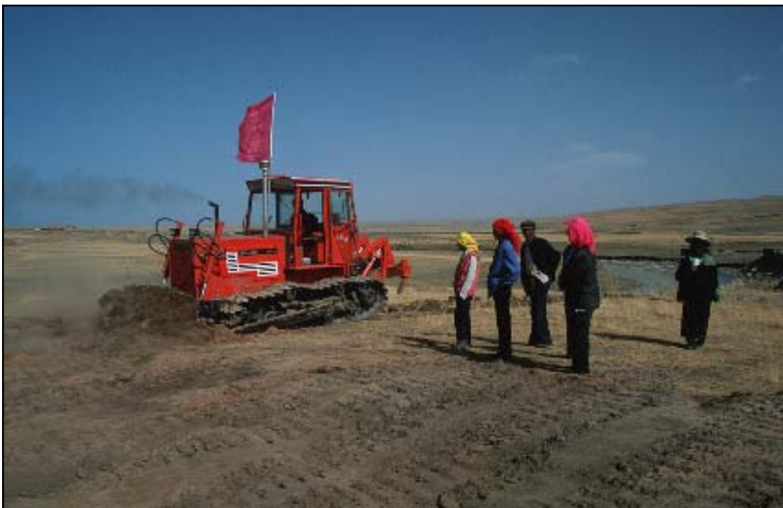
Bau der Pipeline bei Heimaha am Kokonor © Dr. Axel Gebauer
