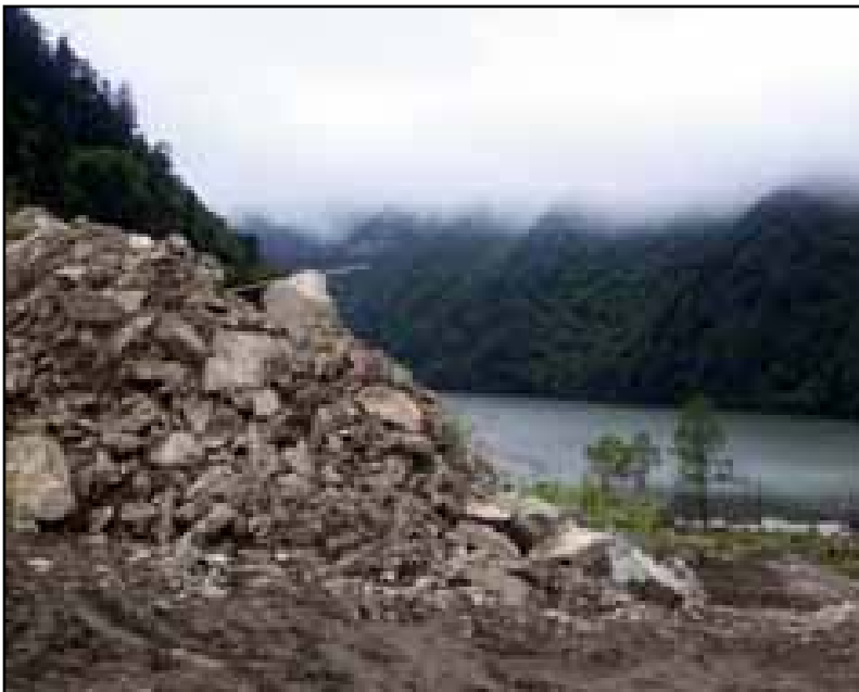
Erdarbeiten am Renzonghai © Tashi Tsering, TJC
